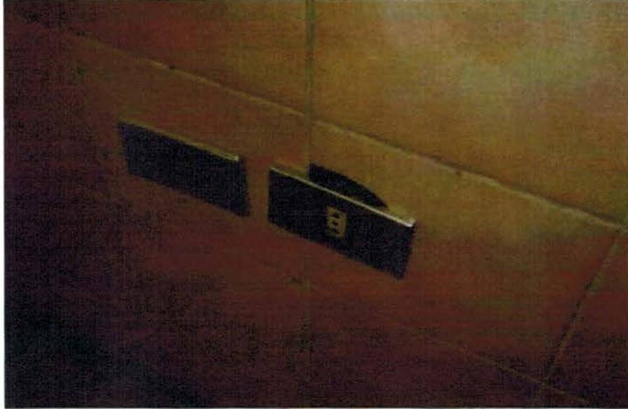
Foto N° 4: Revestimiento de muro quebrado en sector de toma corriente (enchufe) en patio techado de acceso a comedor
