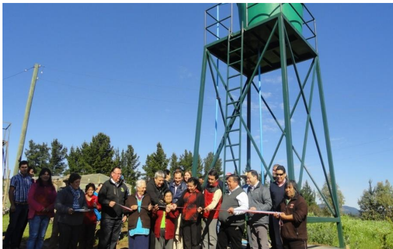
“Esta torre abastecerá de agua potable a las 56 familias del sector las perdices”.
