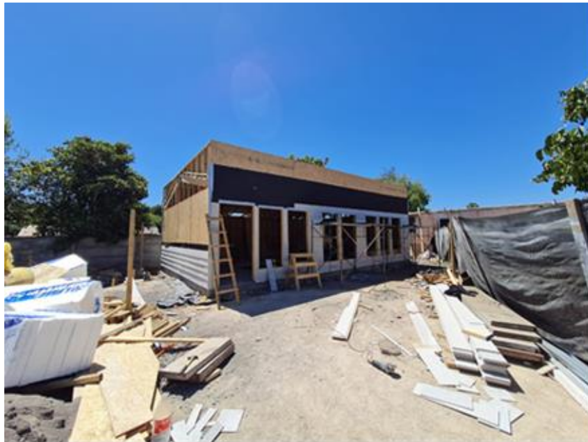
“Construcción Salón Multipropósito CECOSF, Cerro Negro”
