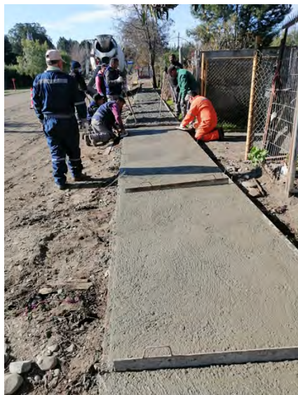
Obra: "Construcción espacio público Batalla El Roble, Quillón"
